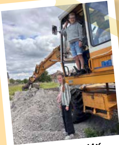
DE GRAAFMACHINE AAN HET WERK
